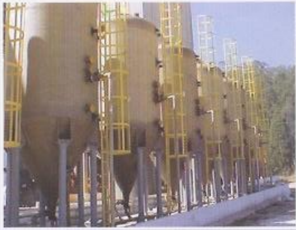
Tanques de Processo para Sulfato de Alumínio
